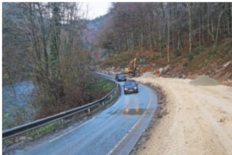
Po udoru cestišča ob avgustovskih poplavah v Soteski že poteka rekonstrukcija dobrih 360 metrov dolgega odseka. / Foto: Gorazd Kavčič
